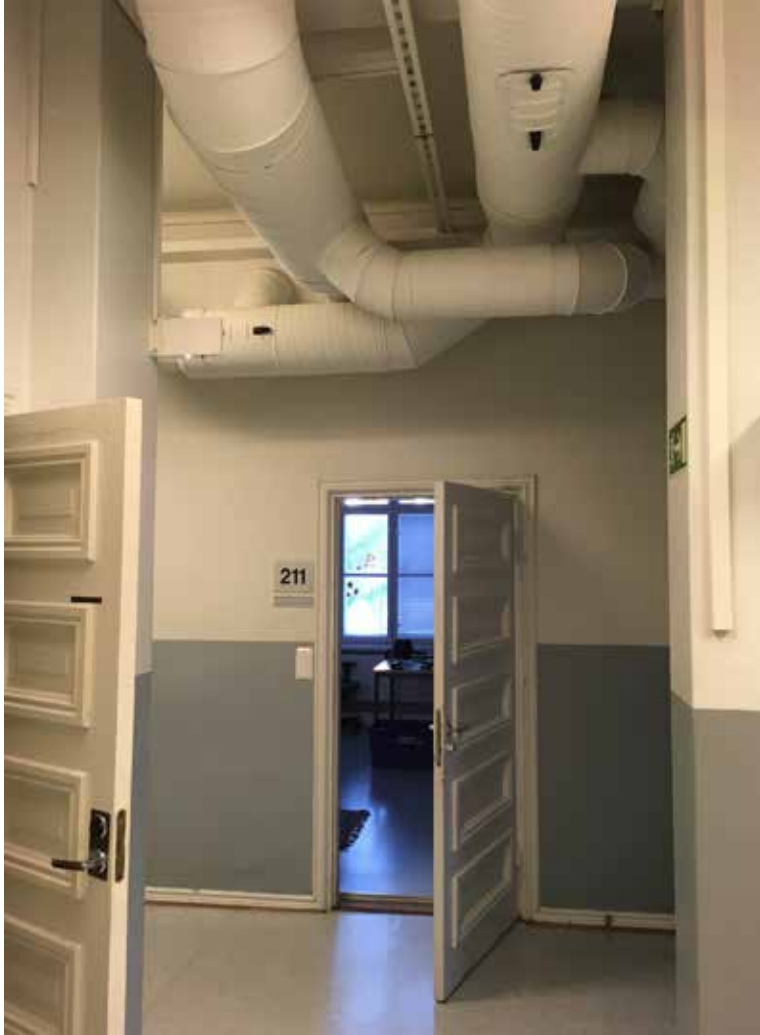
Näkymä 2. kerroksen käyvältä. Puurakenteiset peiliovet ovat 1930-luvulta, tilapinnat ja talotekniikka pääosin 2000-luvulta.
