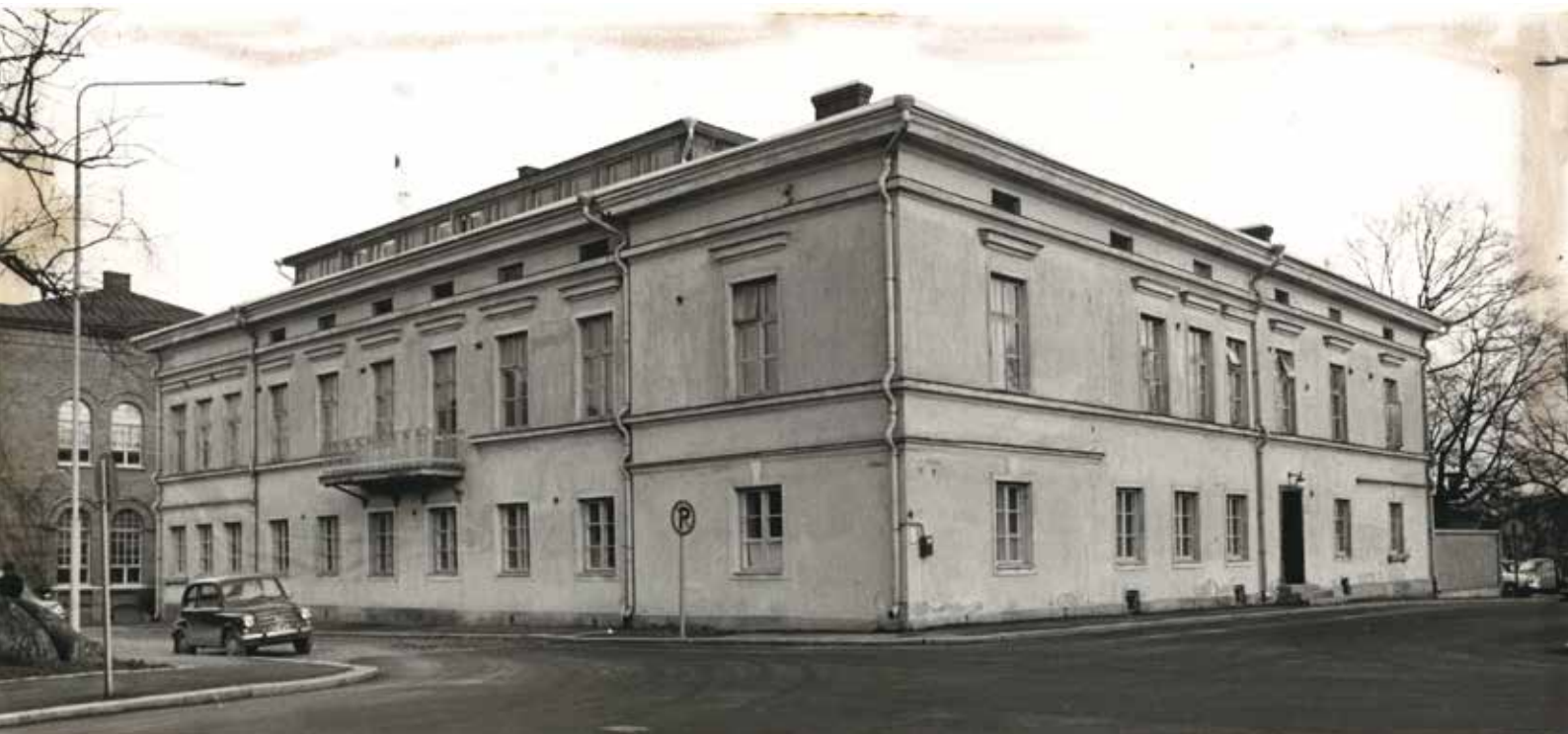
"Kaupunginhallituksen talo, vuodesta 1967 Katuosasto". Frenckellin tehtaan portit ja osa kiviaidasta on purettu. Kirkkokatu jatkuu rakennuksen länsisivulla. Valokuvaaja Veikko Lintinen. TMKA
