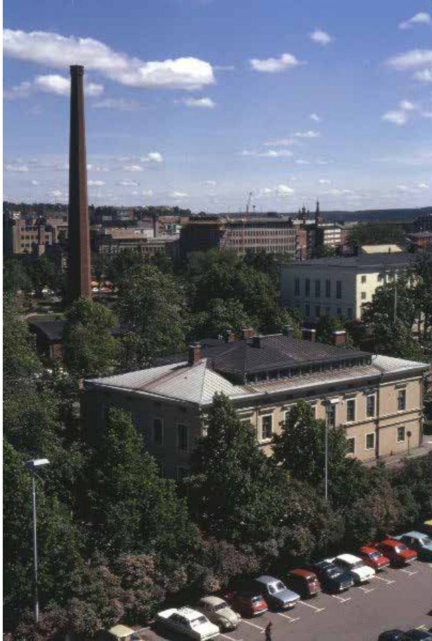
"Frenckellin tehtaan entinen konttorirakennus - sittemmin Tampereen kaupungin käytössä". Valokuva 1960-luvulta. Vasemmalla Frenckellin panuhuoneen savupiippu. MV
