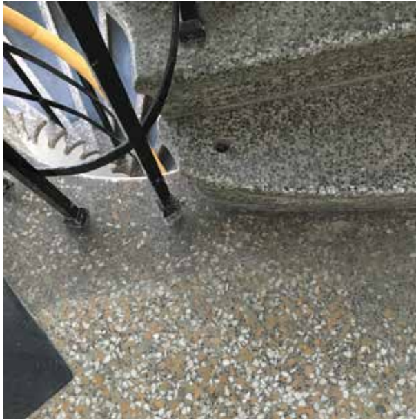
Porrashuoneen 2. kerroksen lattia. Tasanteen okrasävytteinen mosaiikkibetonipinta 1930-luvulta, porraskelmien hineorakeisempi mosaiikkibetonipinta 1940-luvulta.
